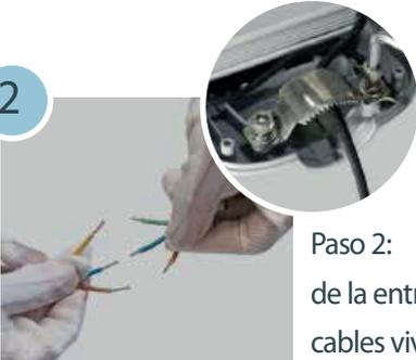
Paso 2: Pase el cable a través de la entrada y conecte los cables vivo, neutro y tierra.
