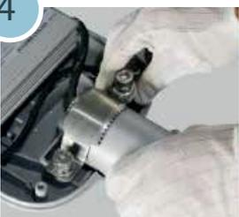
Paso 4: Monte la luminaria en el poste a través del tubo hasta que haga tope, acomode y luego aprete los dos tornillos de montaje.
